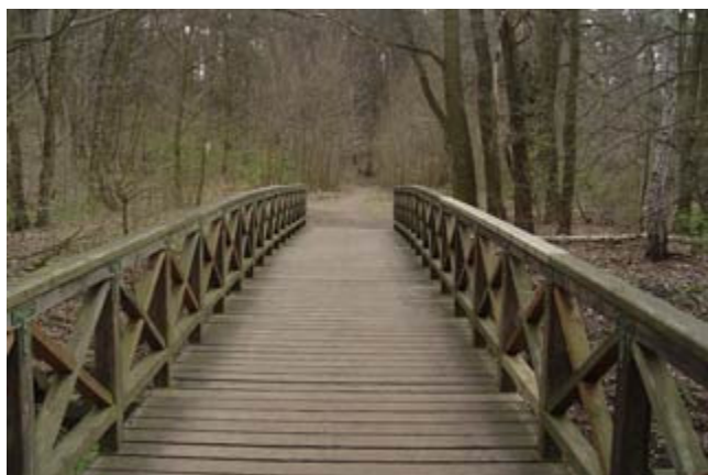
Brücke über Langes Luch
