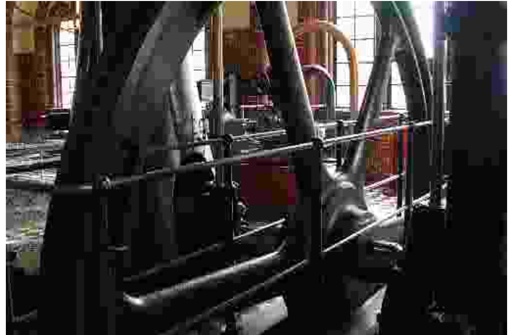
Ursprünglich wurden seine Pumpen mit schlesischer Steinkohle angetrieben.
