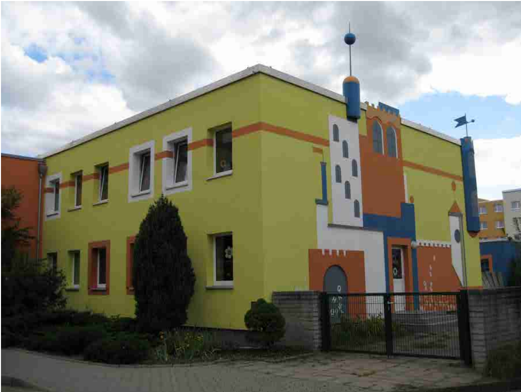
Alle Gebäude wurden farbenfroh mit einem jeweils eigenen Stil versehen (Kindergarten).
